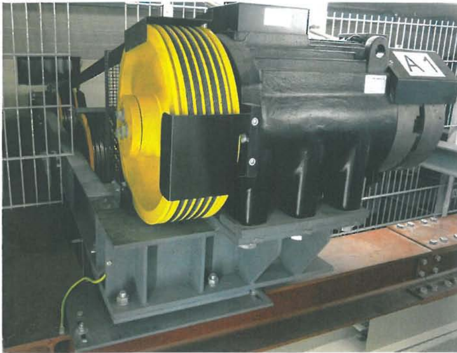
Antrieb neu: Ziehl-Abegg Gearless Antrieb New drive: Ziehl-Abegg gearless drive
