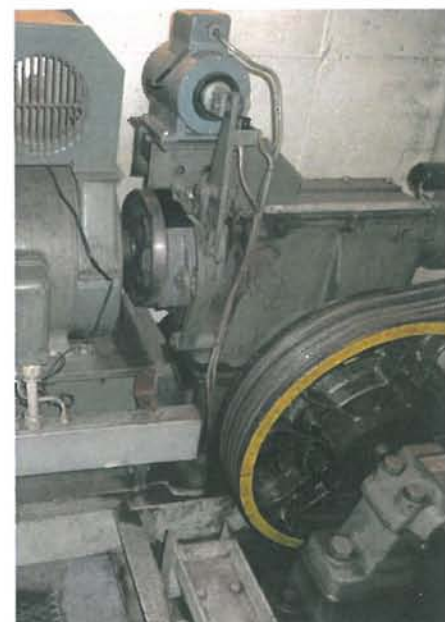
Antrieb alt: Schneckengetriebe Old drive: worm gear drive
